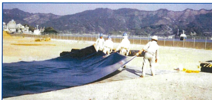
シート敷設状況
